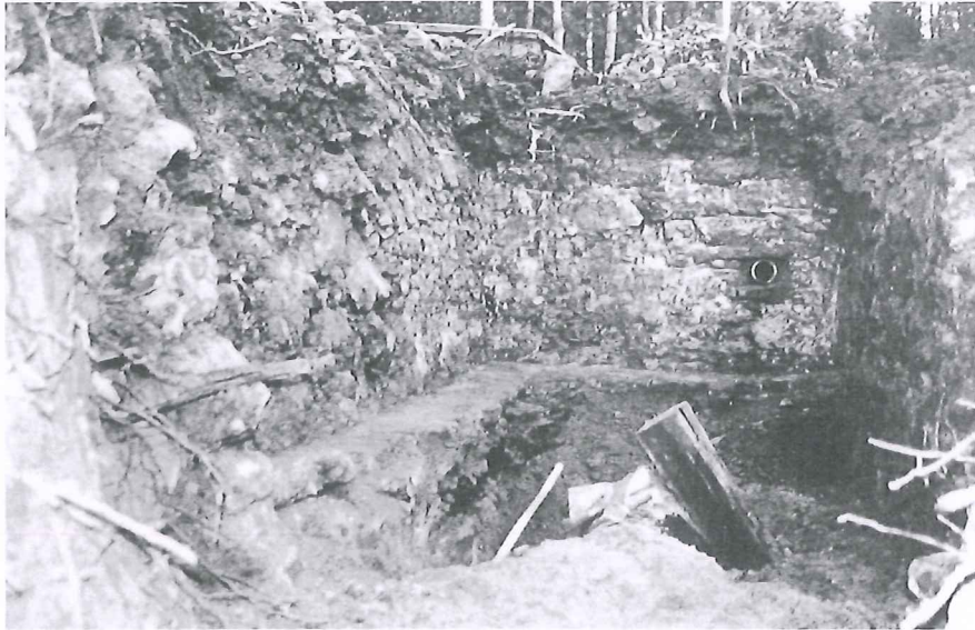
Abb.3: Das Klärbecken der Quellwasserleitung von 1806/07 ist hier vom Bagger aufgerissen worden, die hintere Wand wird ebenfalls der neuen Leitung weichen. Das neue Teilstück der Herrenstrundener Leitung wurde mitten durch die fast 200 Jahre alte Anlage verlegt. Im Hintergrund ist der Einlauf der alten Leitung zu sehen, im Vordergrund liegt schon ein Teil der neuen Leitung unter Sand.
